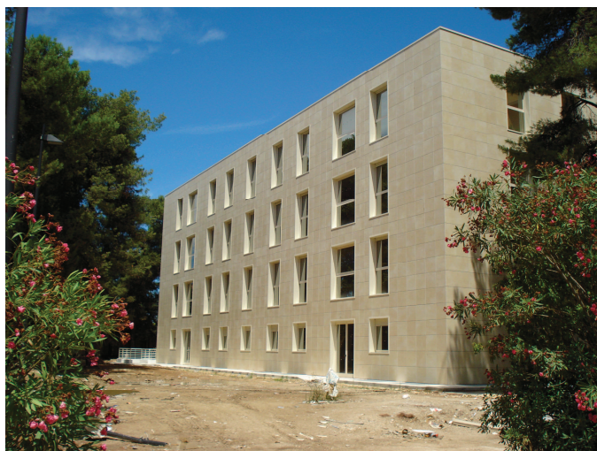
Figura 25 - prospetto edificio per uffici
