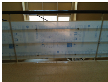
Figura 8 - protezione balaustre (nella foto, la lastra trasparente è protetta con un foglio di plastica da rimuovere)
