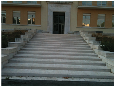
Figura 11 - rampa di scale di accesso di nuova edificazione
