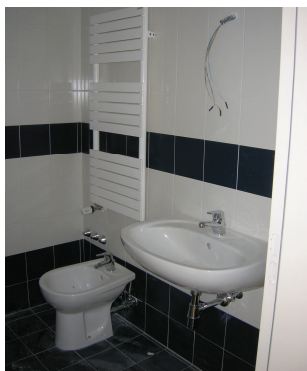
Figura 14 - pavimentazione e rivestimenti dei servizi igienici
