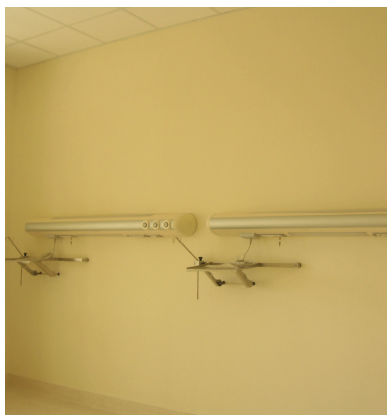
Figura 15 - rivestimento delle pareti in idropittura
